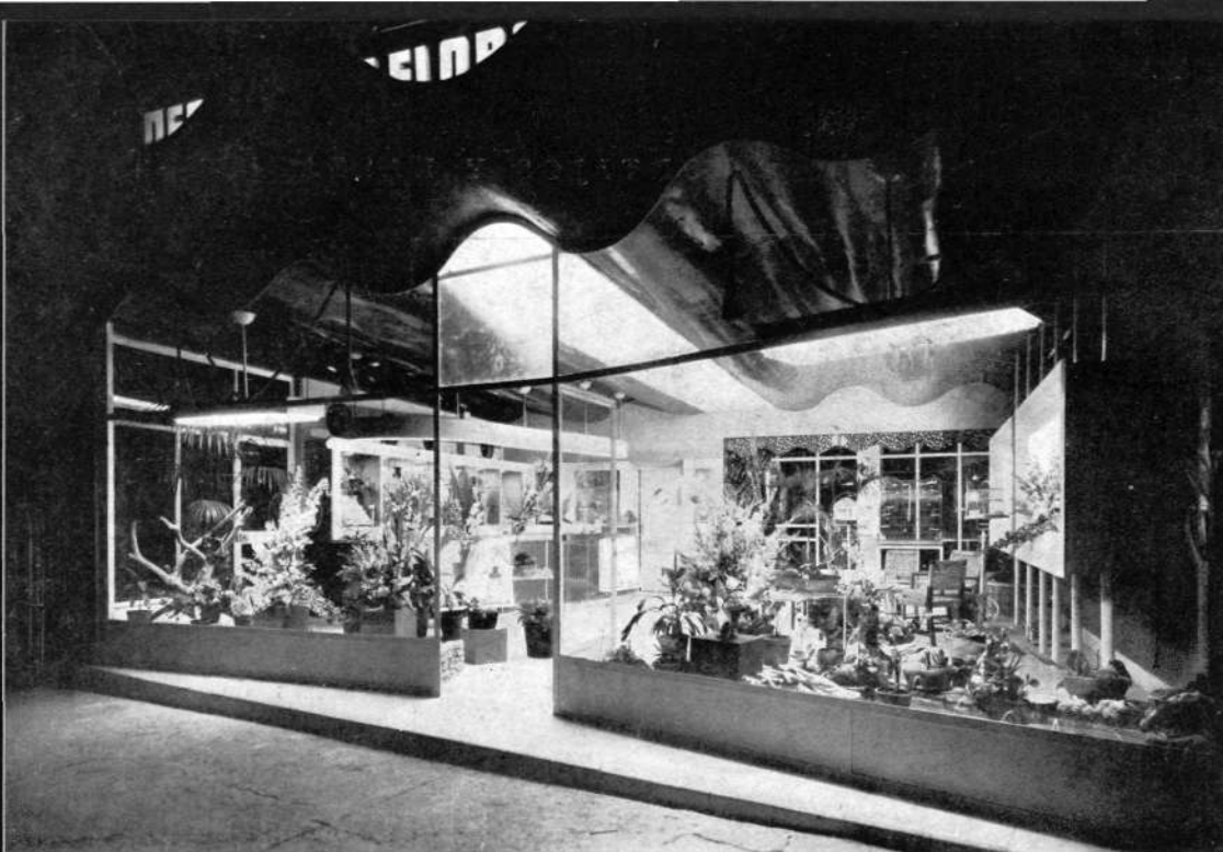
Fachada del negocio, con rótulos de plástico translúcido iluminado interiormente, losa ondulada de 6 cm. de espesor y 80 metros cuadrados de superficie sin ningún apoyo intermedio.
