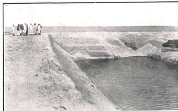
Estado actual de las obras en la bocana de Mar Chica. El muro que separa los dos mares tiene ya solamente cinco metros de espesor
