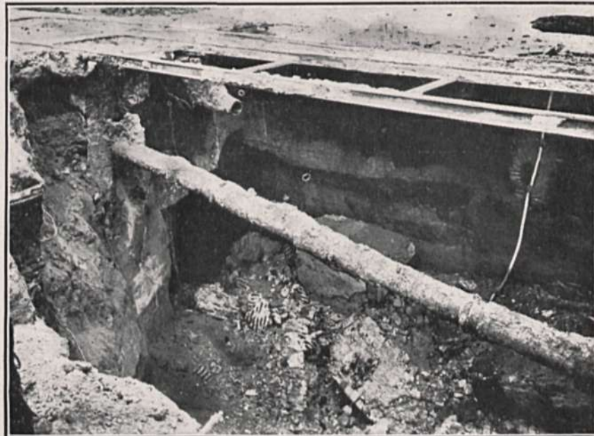
Detalle de la sima que quedó al descubierto al hundirse el pavimento de asfalto
