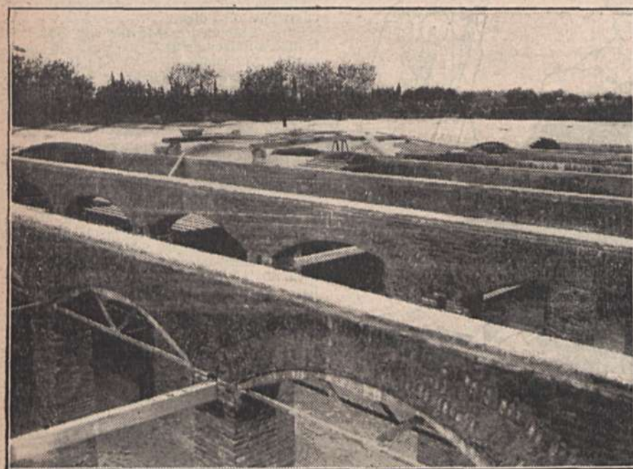
Una de las mejoras más importantes que se están realizando en dicha capital es la construcción de los nuevos depósitos para el servicio público de aguas potables, cuya cabida es de unos 16.000 metros cúbicos. Con la terminación de estas obras se hará el abastecimiento de un modo eficaz, garantizando las exigencias de la moderna higiene
