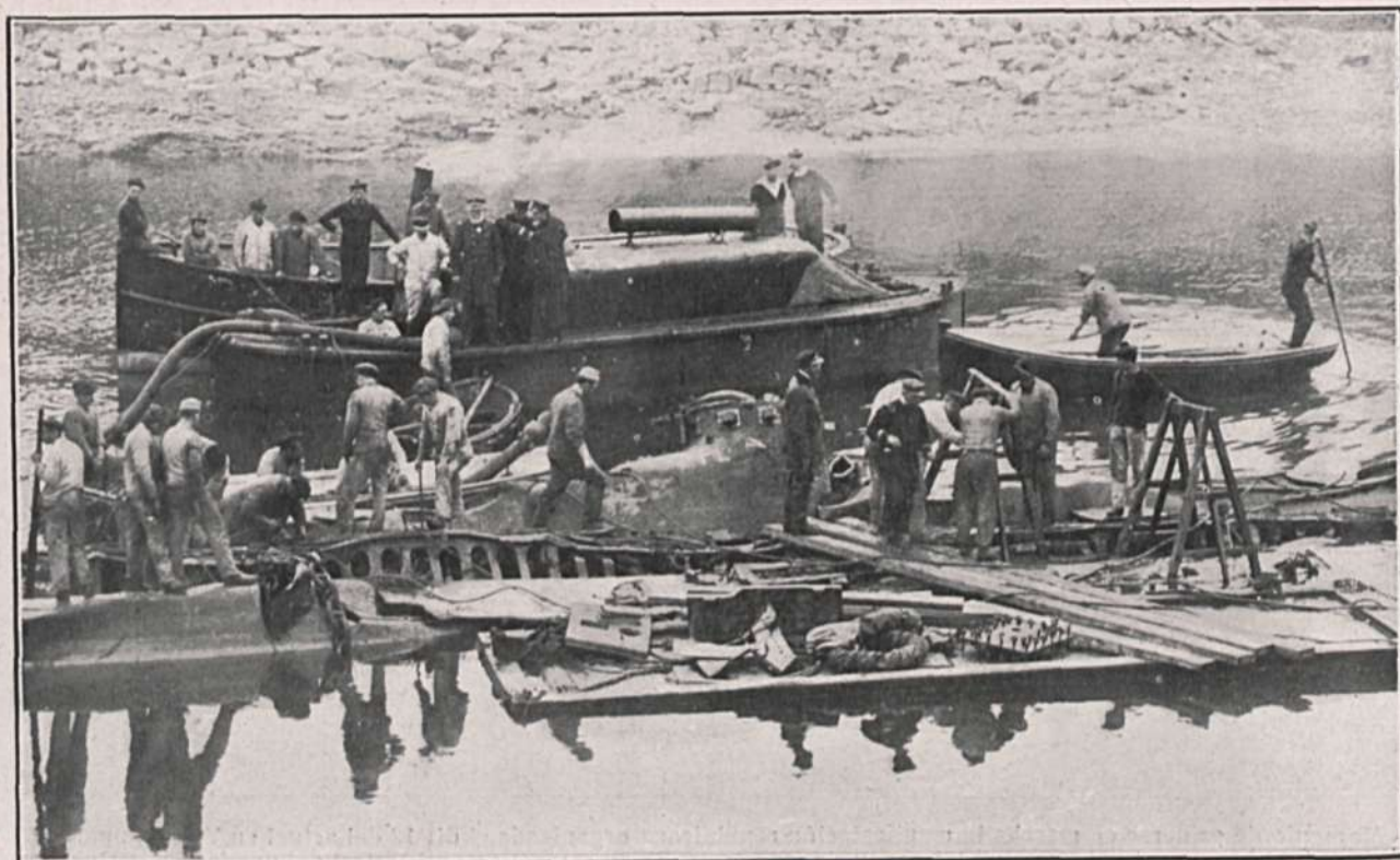
Perforación hecha en el casco del "Pluiose" para la extracción de los cadáveres de las víctimas
