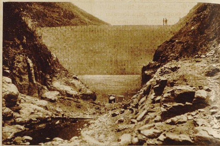
Paramento de aguas arriba de la presa en construcción del Barranco de Lezcano. Sobre los bloques del paramento, en la roca de las márgenes, se observa la mancha blanca que marca el nivel que alcanzaron las primeras aguas embalsadas
