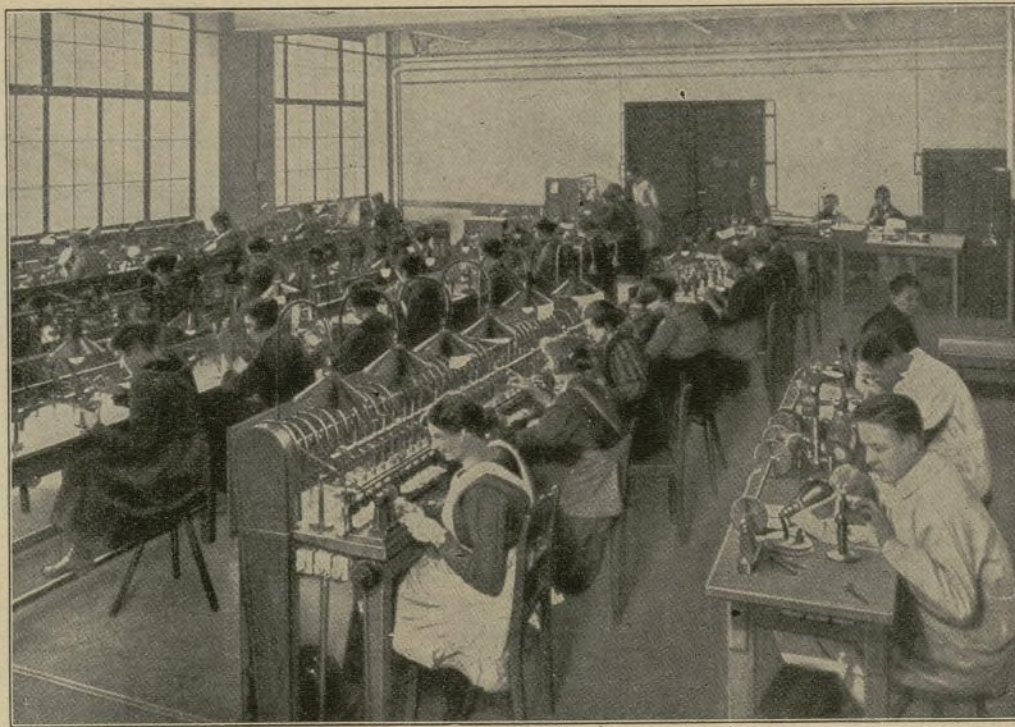
Fig. 2. Fabricación de las hileras para el estirado de los finisimos alambres de tungsteno.
