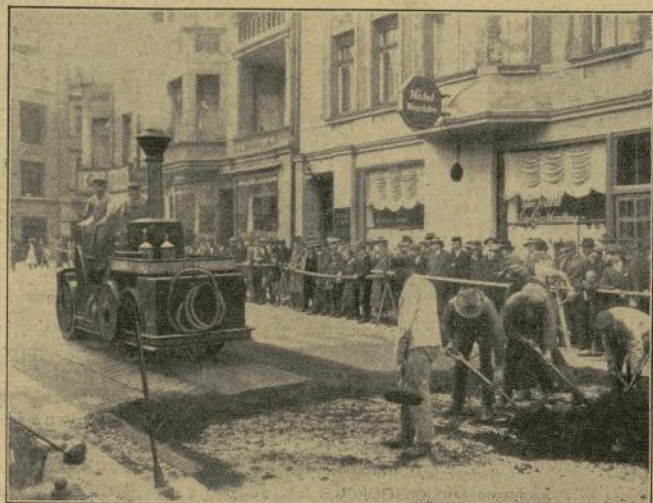
Asfalto comprimido «Jeserit» formando una capa de recubrimiento sobre base de hormigón en sustitución del entarugado.
