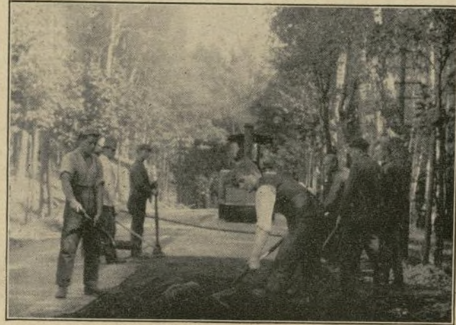
Colocación y compresión de la capa de recubrimiento de asfalto enarenado.
