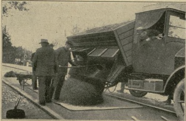
Descarga del producto mezclado caliente. (Wayss & Freitag, Frankfurt a. M.)
