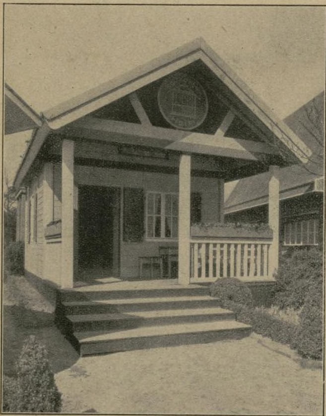
Casita de campo de piezas normalizadas con las cuales puede modificarse el aspecto de la construcción a voluntad del poseedor.
