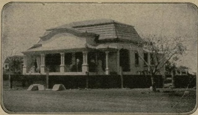
Casa construida en Loanda con ladrillos Ambi en 50 días.
