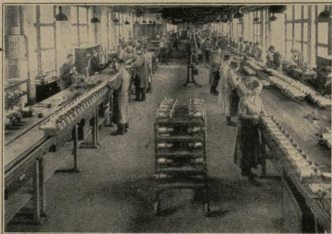
Montaje de dinamos y magnetos.
