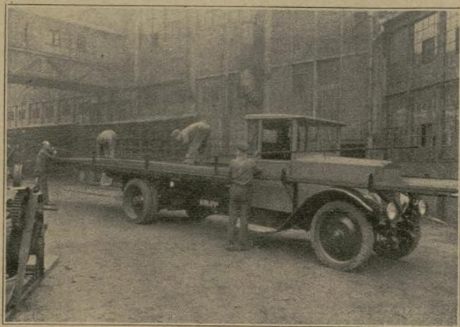
Camión automóvil de 5 toneladas con plataforma y prolongación móvil para el transporte de barras de hierro y hierros perfilados.
