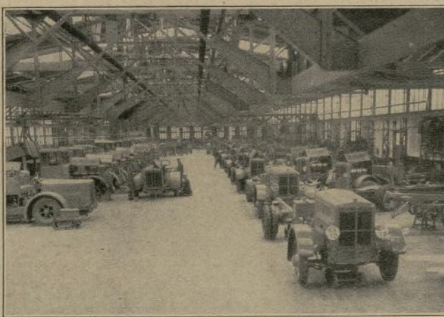
Montaje de potentes camiones automóviles aplicando el sistema del trabajo continuo.
