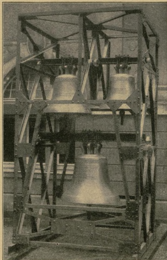
Armazón de hierro para la suspensión de 6 campanas de bronce accionadas eléctricamente.
