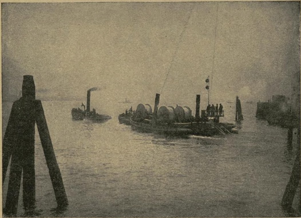
Colocación de un cable de 25.000 voltios en Rotterdam.
