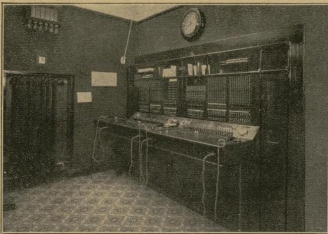
Central postal de estaciones secundarias del sistema semiautomático Lorenz.
