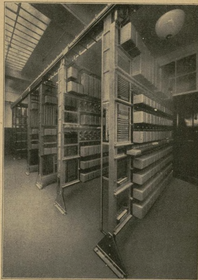
Central de conexiones automáticas sistema Lorenz para 400 abonados.
