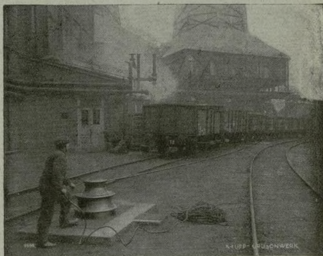
Fig. 4. Desplazamiento de vagones por medio de cabrestante eléctrico y cable Sistema Krupp-Grusonwerk
