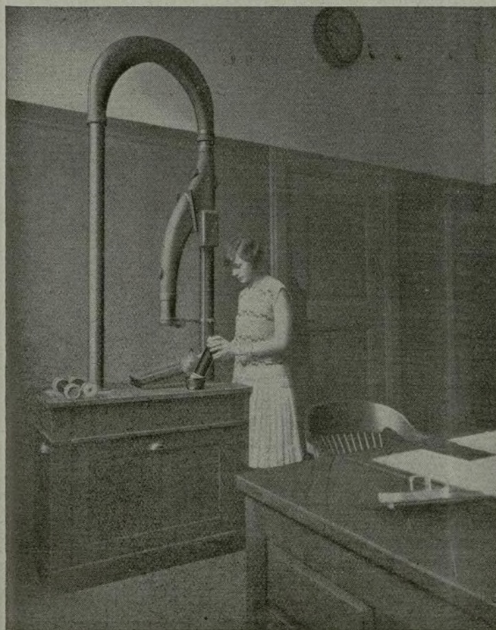
Estación de correo neumático en el antecámara de un director.
