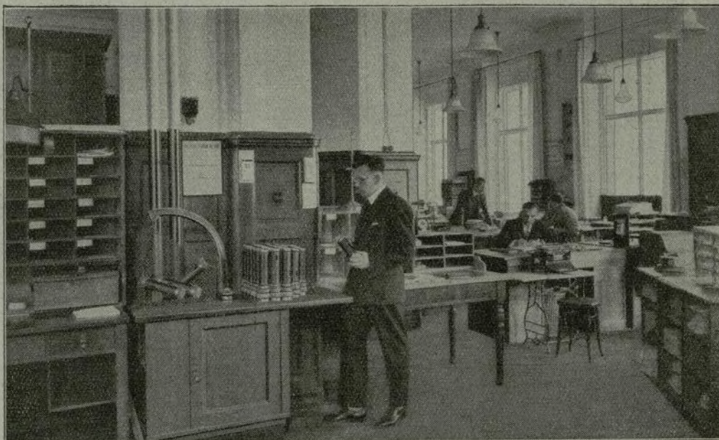
Estación de envío y recepción de una instalación de correos neumáticos
