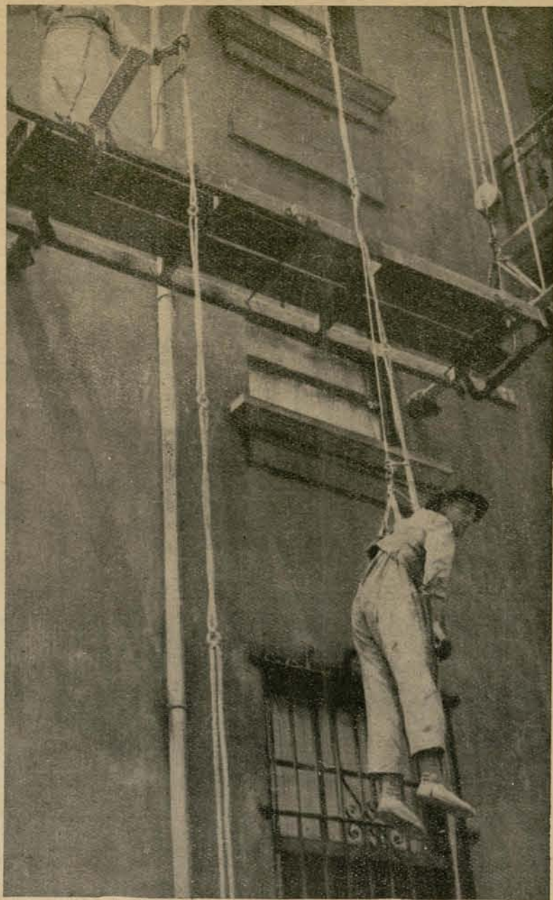
Este cinturón de seguridad se ha establecido, obligatoriamente, en Santander. El Ayuntamiento de esta localidad lo exige en todas las obras. Ofrecemos este ejemplo al nuestro.
