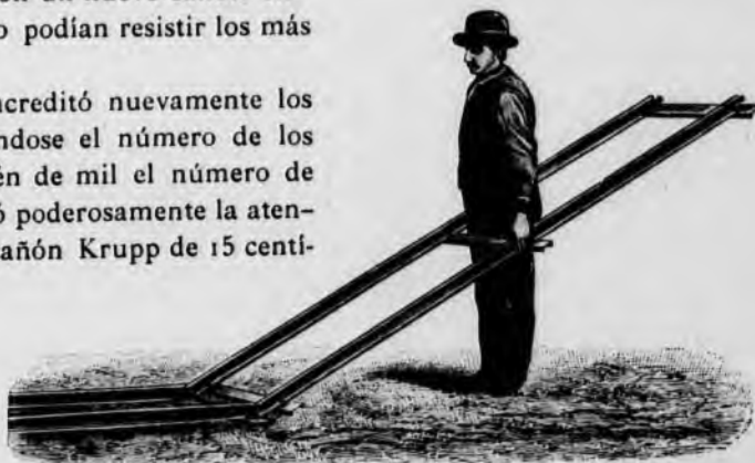
Colocación de rieles para ferrocarriles de campaña
