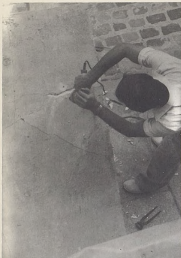
Lam. 8.—Preparación del soporte para su posterior grapado.
