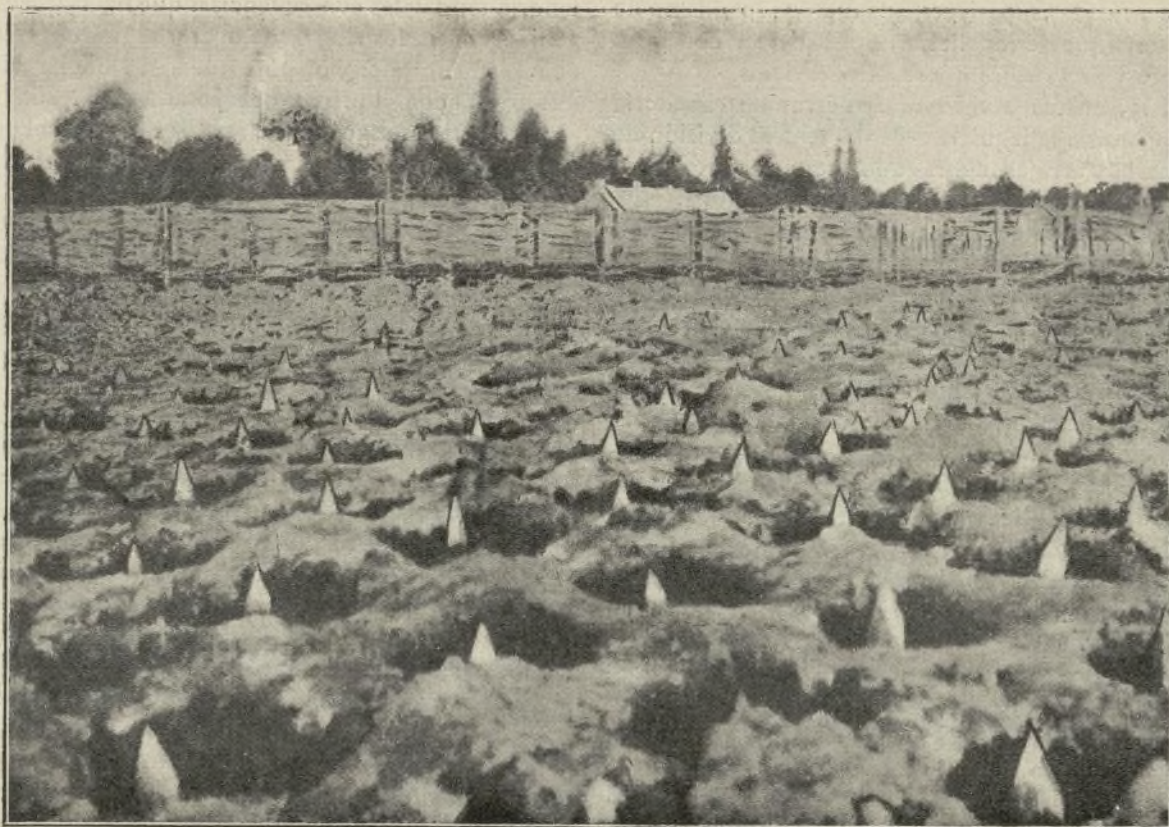
Pozos de lobo abiertos delante de un fuerte francés. (En el centro de cada uno, un fuerte piquete aguzado). En segundo término, líneas de alambradas espinosas
