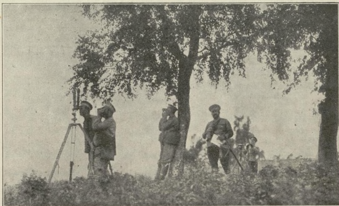
Puesto de observación ruso con anteojos de larga vista (para que los anteojos puedan montarse detrás de parapetos que cubran al observador, los tubos son verticales y los objetivos están en el extremo superior)
