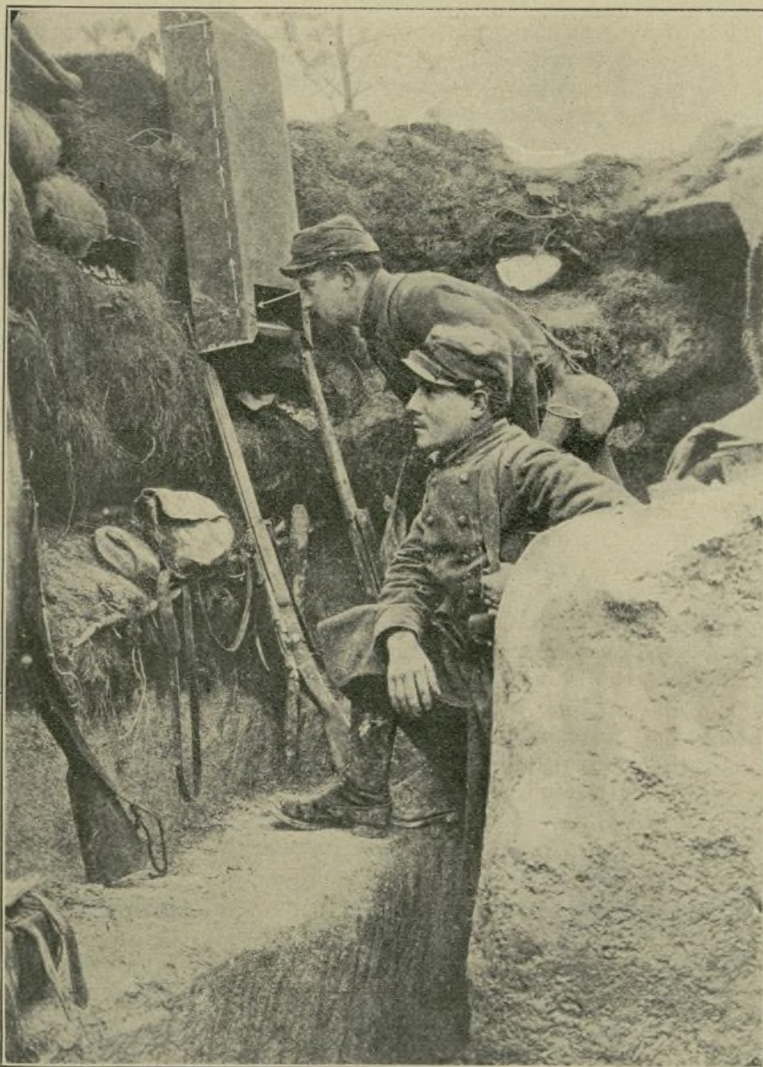
Soldados franceses examinando desde el fondo de una trinchera, por medio de un periscopio improvisado, los movimientos del enemigo; las flechas indican la dirección de los rayos luminosos reflejados por los espejos
