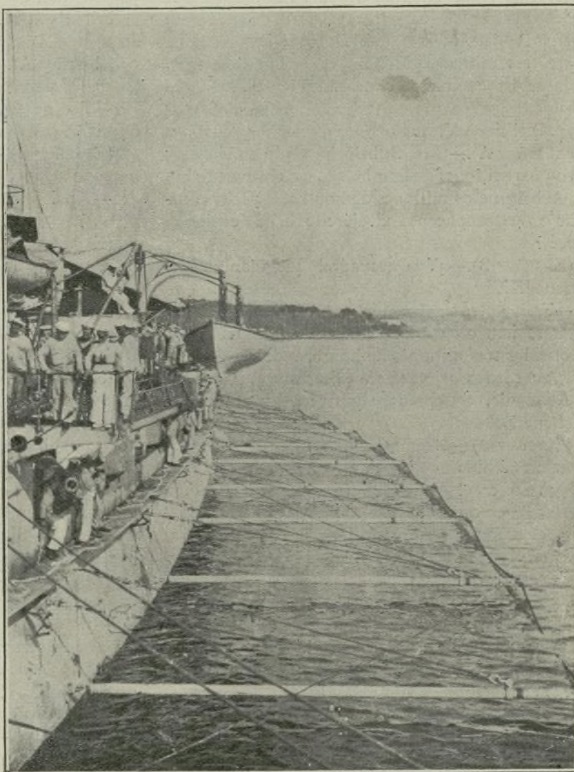
Un acorazado austriaco con las redes Bullivan para protegerle contra los ataques de los torpederos
