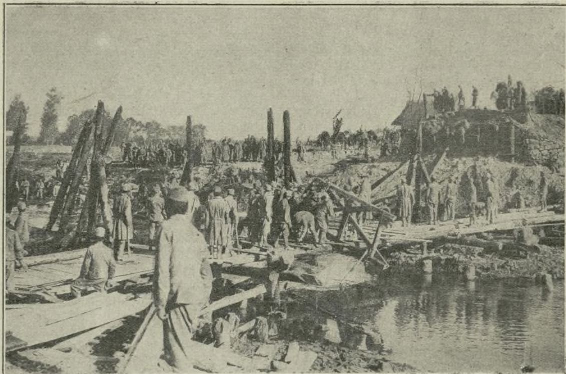
Construcción de un puente de circunstancias sobre un río de Galizia, por los ingenieros austriacos
