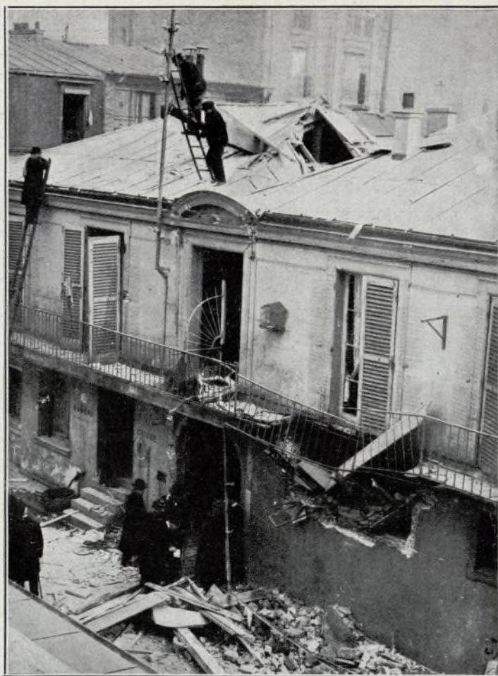
Desperfectos causados en una casa de la plaza de Corneilles, de Levallois, por una bomba de un zeppelin (Fot. Branger)
