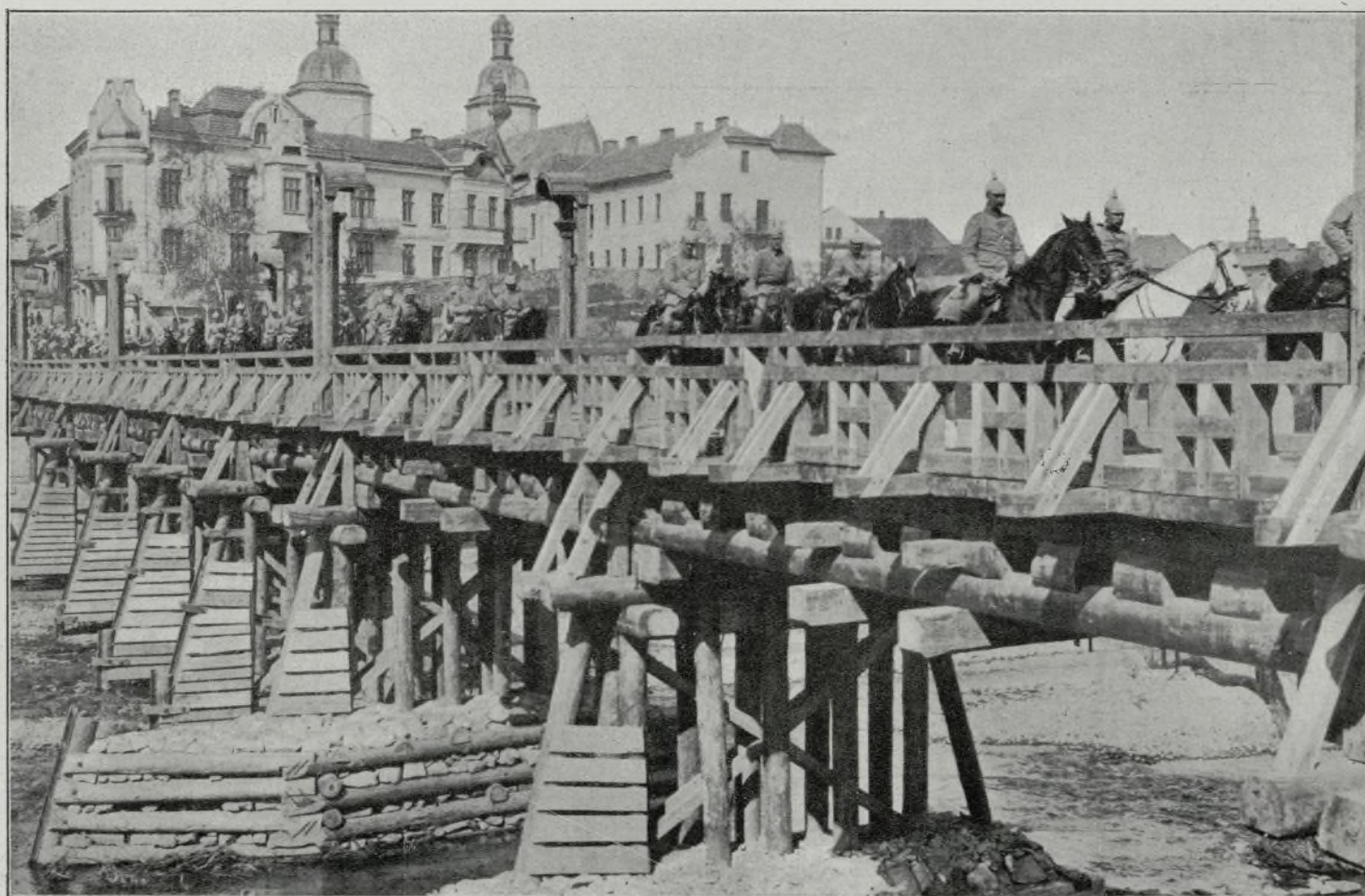
Caballería alemana atravesando un río por un puente de madera construido por ingenieros alemanes
