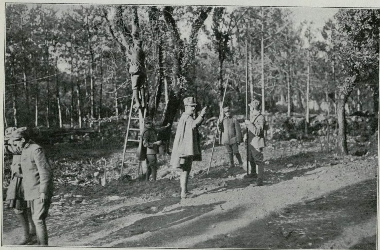
Ingenieros italianos tendiendo una línea telefónica en el bosque de San Valentino, próximo a la primera línea de trincheras (Fot. Argus)
