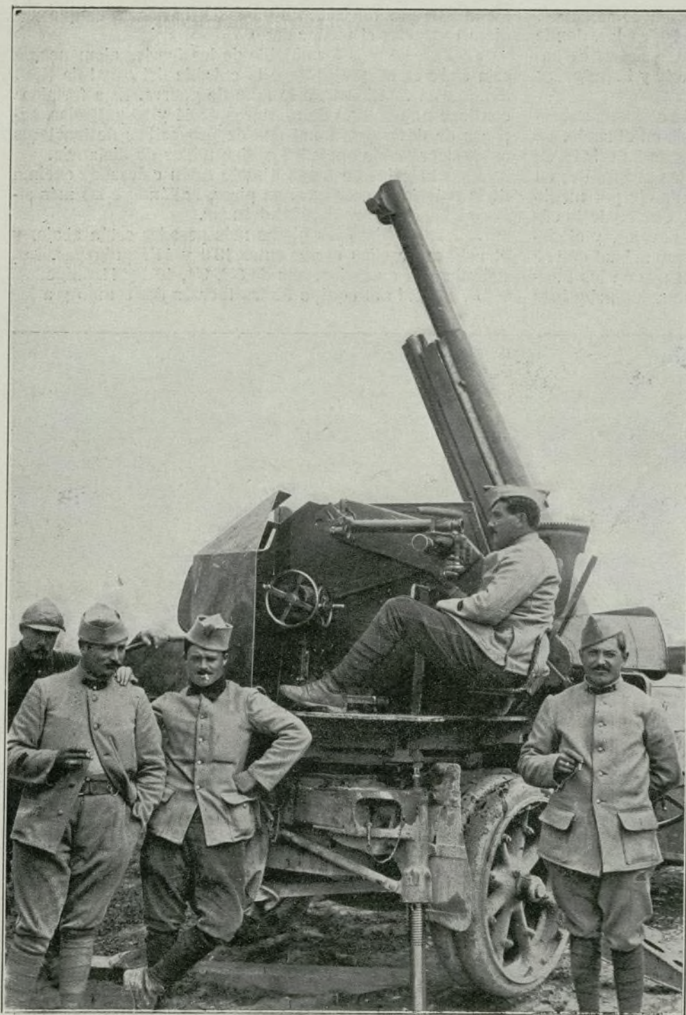
Cañón francés de 75 mm. montado sobre un auto para dar caza a los aviones enemigos (Fot. Branger)
