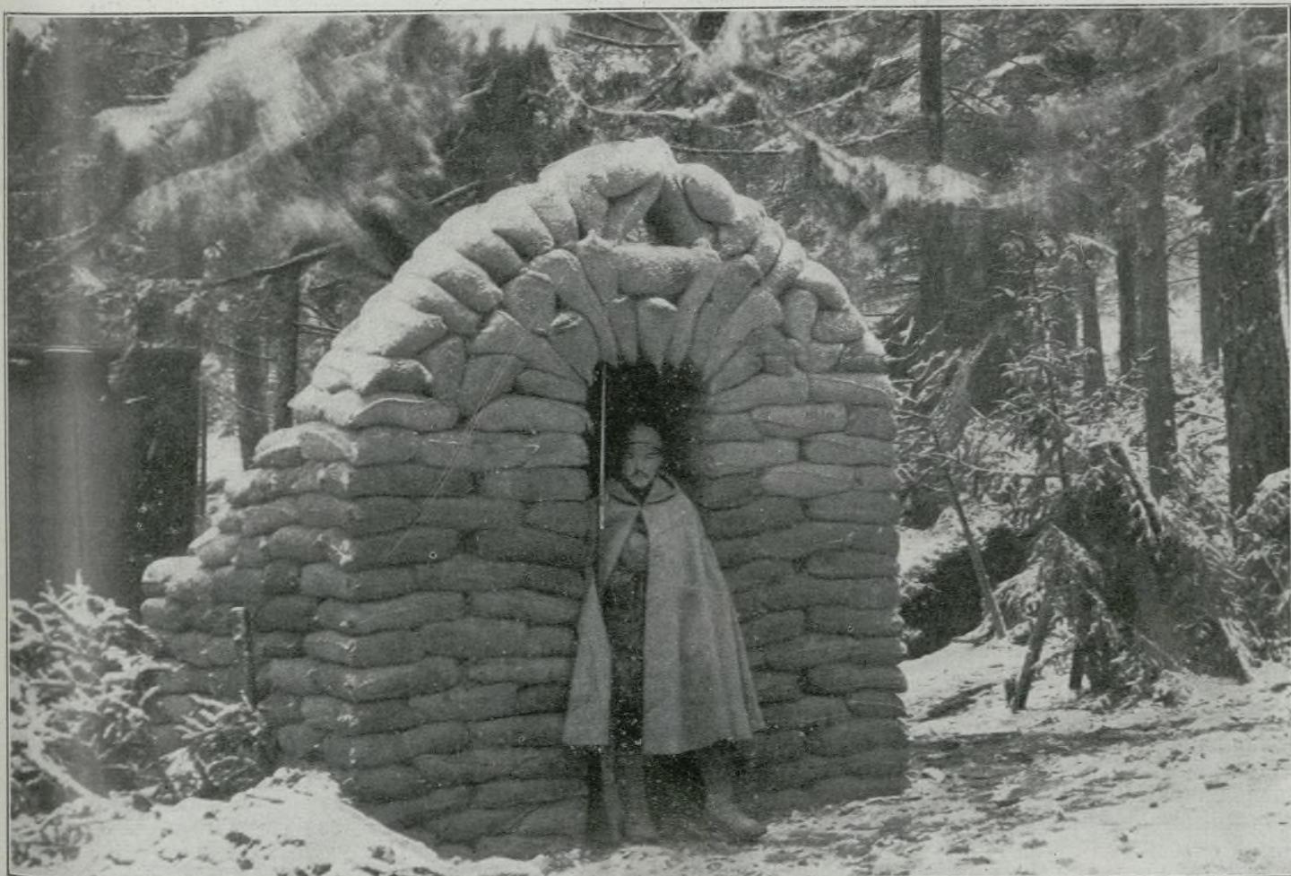
Garita de sacos de arena construída a prueba de metralla en un bosque de los Vosgos (Fot. Central News)
