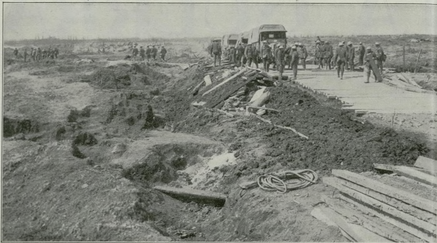
Camino reforzado con maderos por los ingenieros ingleses en la loma de Vimy para el paso de grandes camiones (Fot. Central News)
