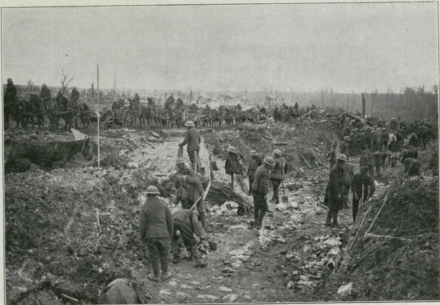
Zapadores e ingenieros ingleses construyendo un camino en la zona conquistada a los alemanes (Fot. Central News)
