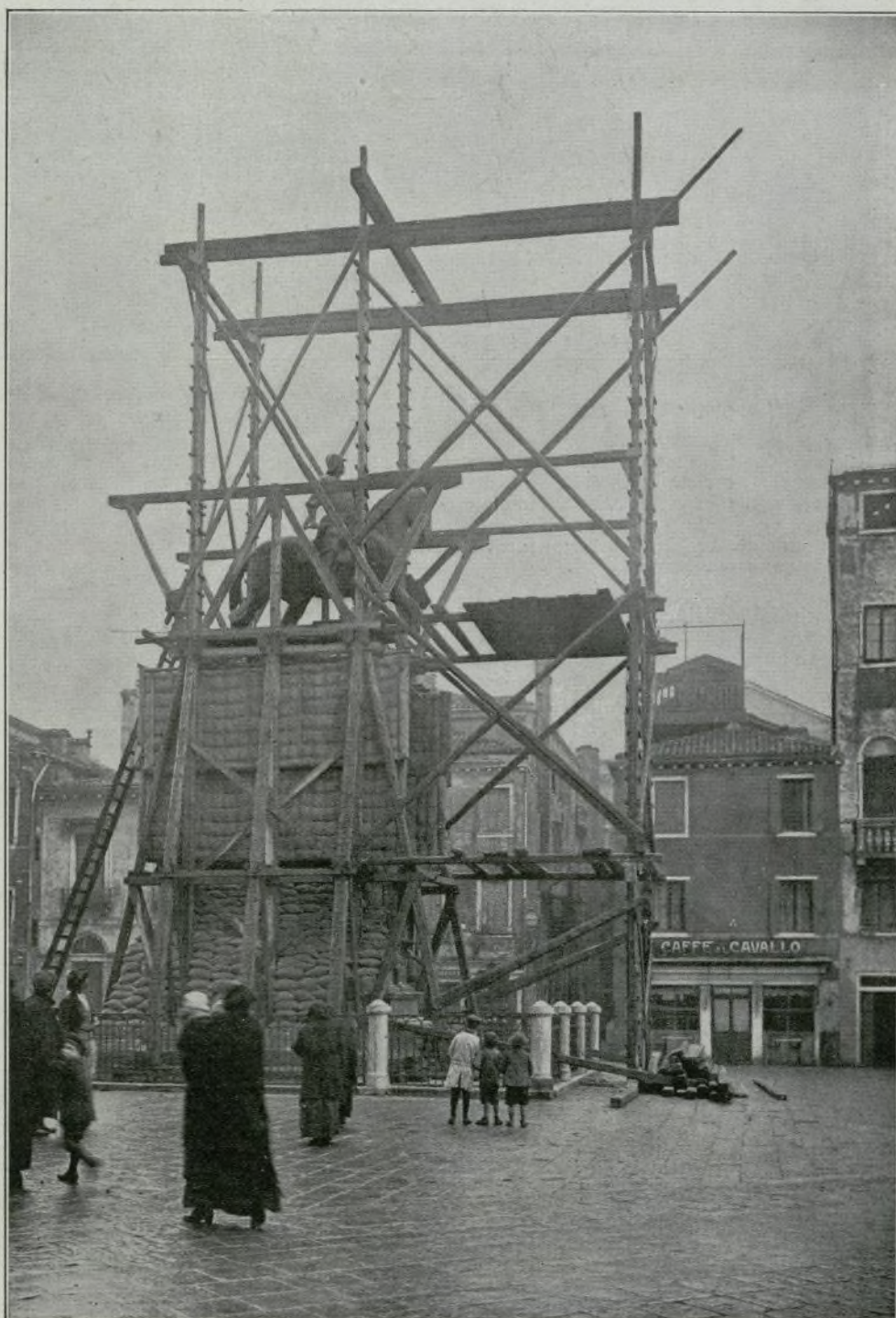
Trabajos de protección del monumento a Colleone, de Venecia, para defenderlo de los ataques de los aeroplanos enemigos
