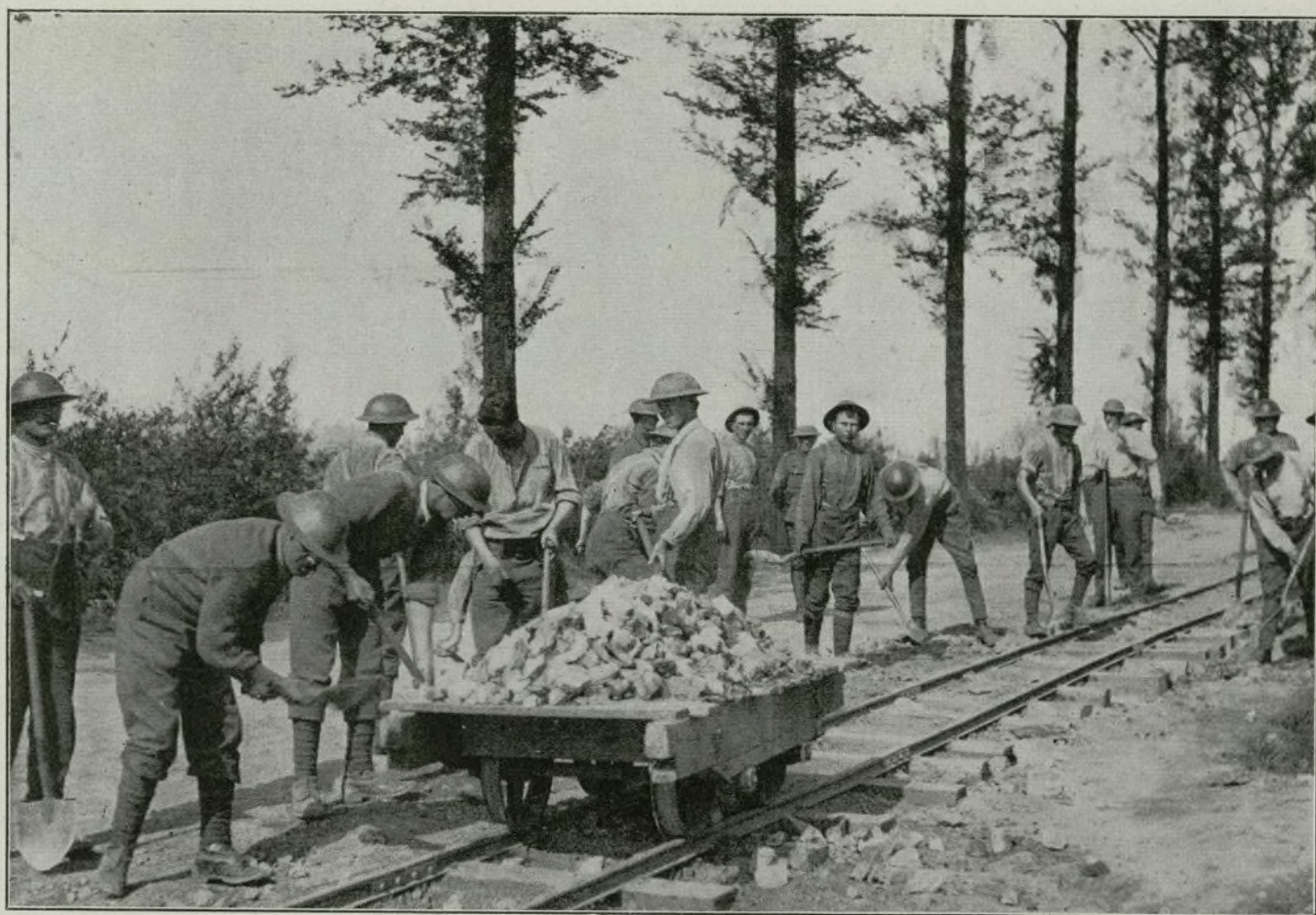
Soldados canadienses ocupados en la construcción de un ferrocarril de vía estrecha cerca de la línea de fuego (Fot. Central News)
