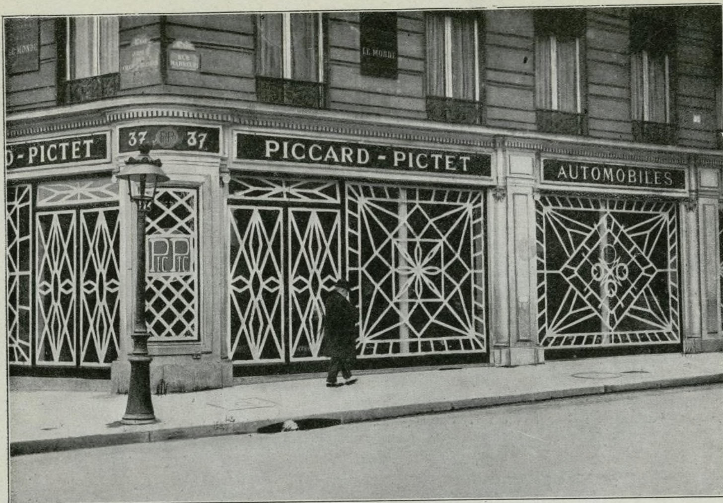
Cristales de una tienda de París protegidos por bandas de papel para aminorar los efectos de las trepidaciones que ocasionan las explosiones de las bombas del cañón monstruo alemán al caer en su vecindad (Fot. Branger)
