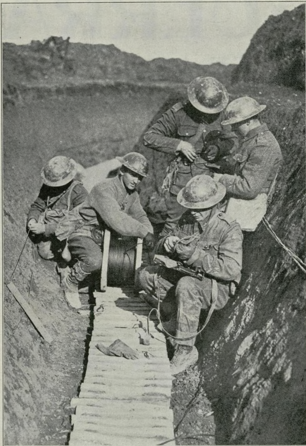
Soldados de ingenieros canadienses reparando los hilos del telégrafo en una trinchera de comunicación del frente occidental (Fot. Central News)
