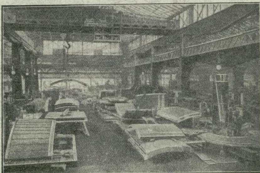
Taller de ajuste de las planchas de blindaje para acorazados.
