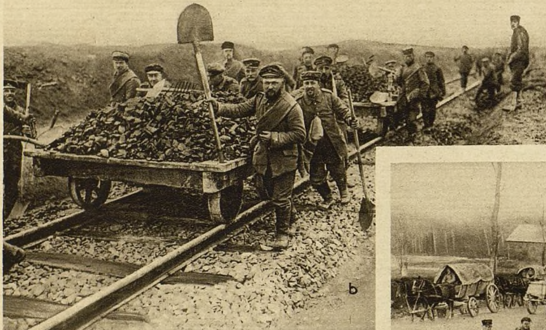
Deutsche Eisenbahntruppen. a) Bauen der Geleise, b) Herbeischaffen des Schotfers.
