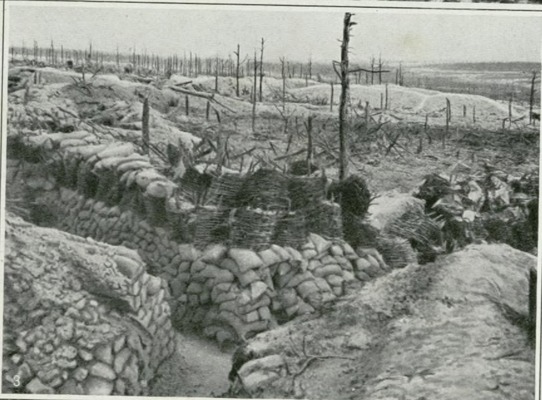
1. Entonnoir de mine organisé défensivement. — 2. Trou Bricot et tranchée d'York. — 3. Trou Bricot : tranchée allemande construite avec des sacs de terre.
