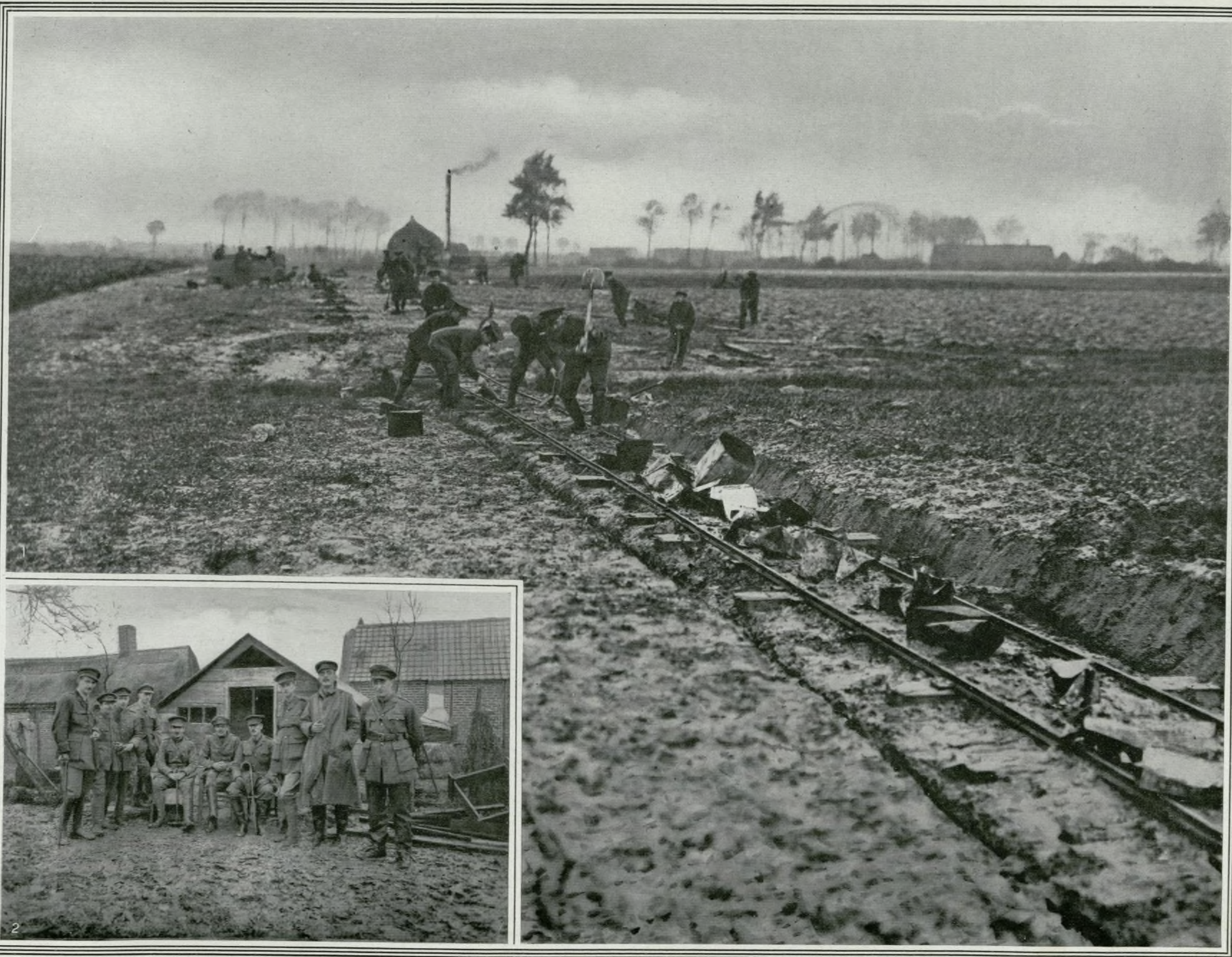
Camp anglais : 1. Consolidation de terrain, à l'aide de boîtes de conserves vides pour un chemin de fer à voie étroite. — 2. Groupe d'officiers.
