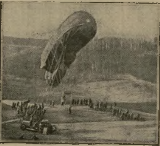
Suivant la direction du vent, l'auto-treuil prend place dans un angle du terrain.
