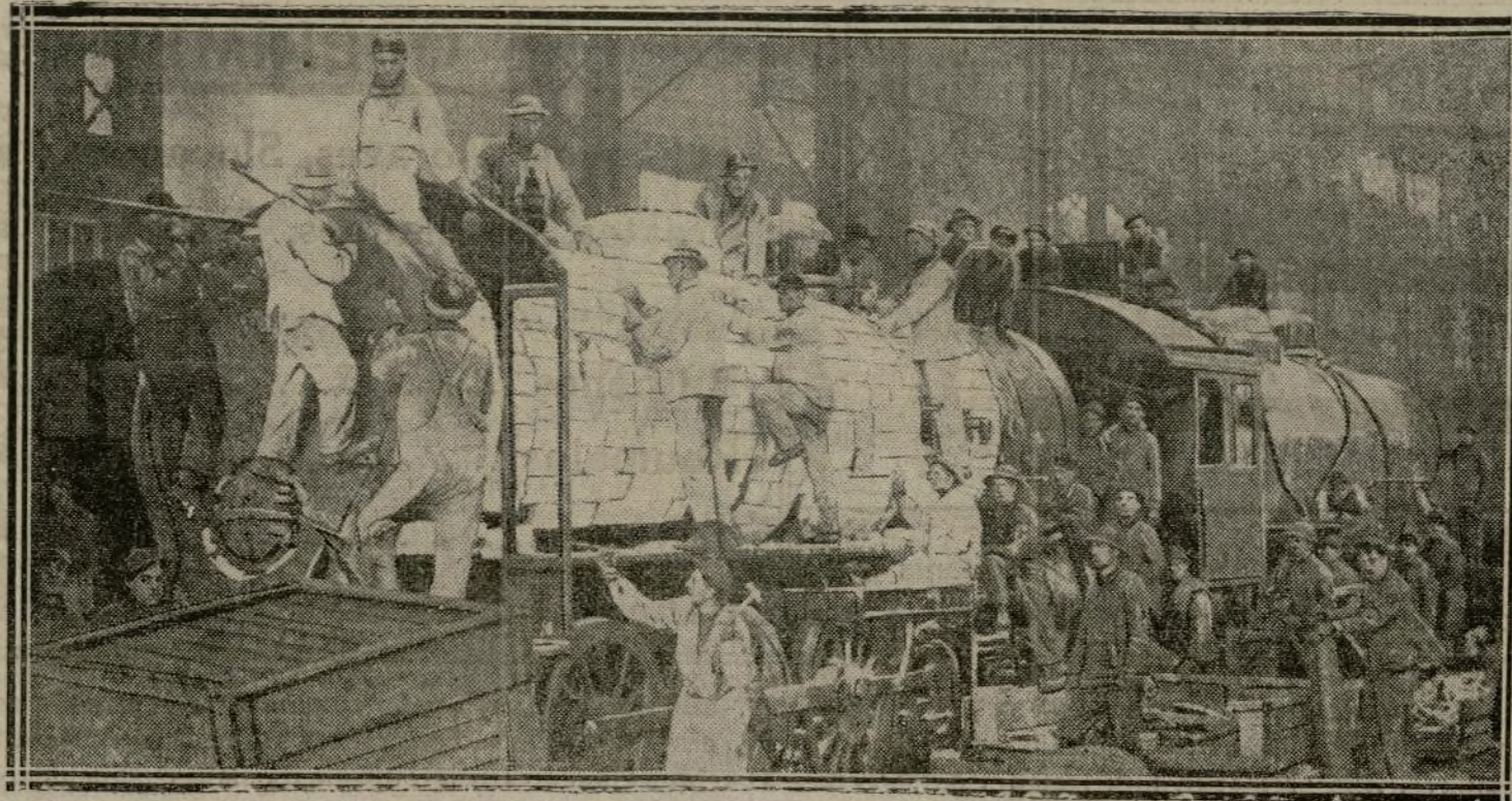
MONTAGE D'UNE LOCOMOTIVE AMÉRICAINE ARRIVÉE EN FRANCE EN DIX-NEUF PIÈCES (Phot. film américain.)
