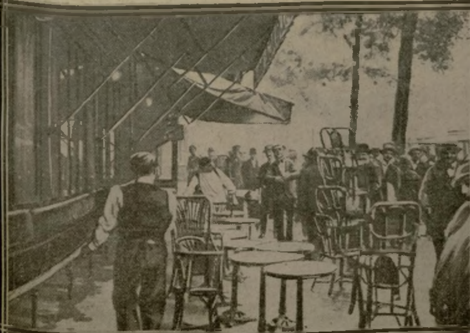
11 HEURES : ON DÉMÉNAGE LES TERRASSES DES CAFÉS
