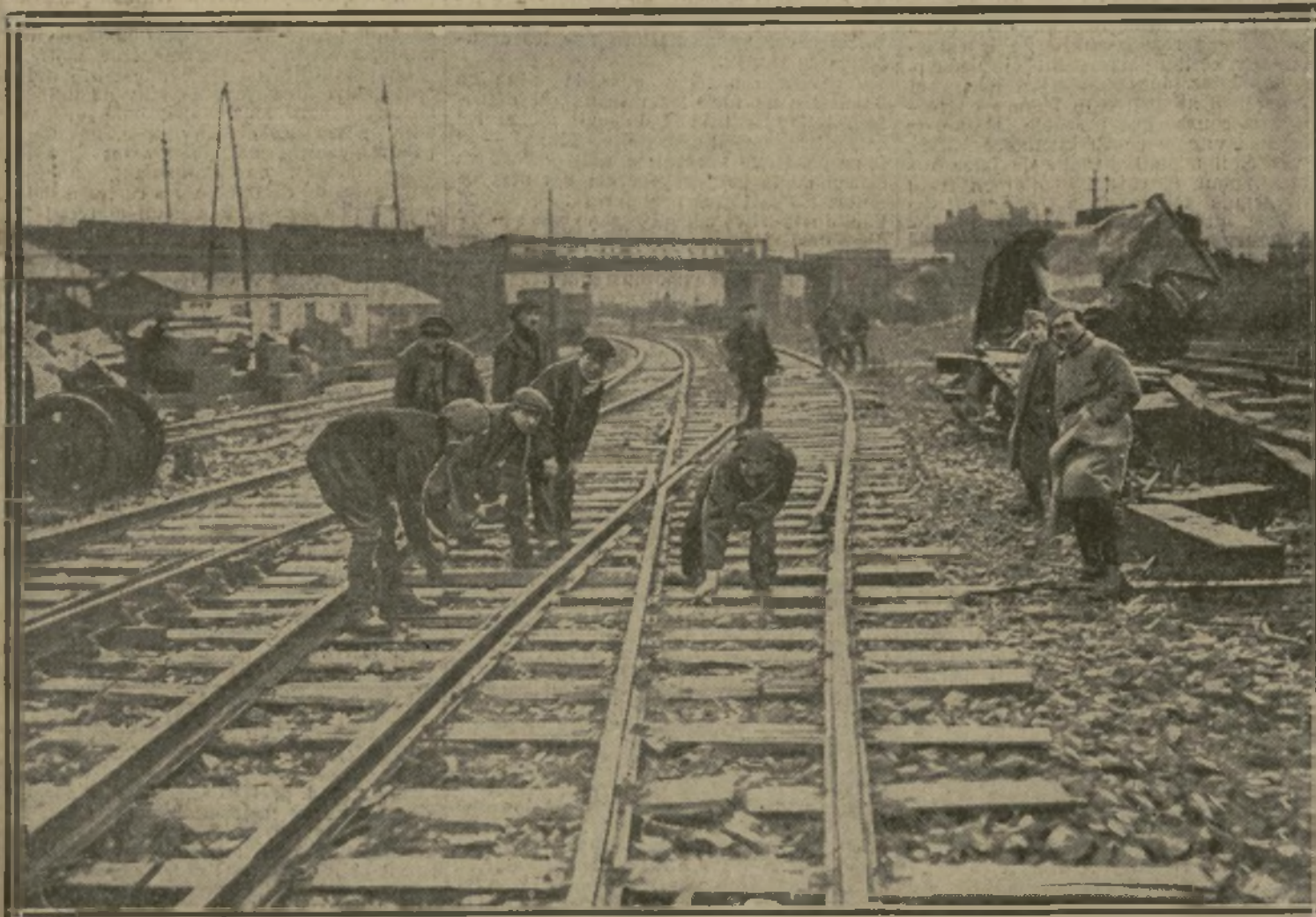
ON RÉPARE LA VOIE AU POINT PRÉCIS DE LA RENCONTRE DES TRAINS
