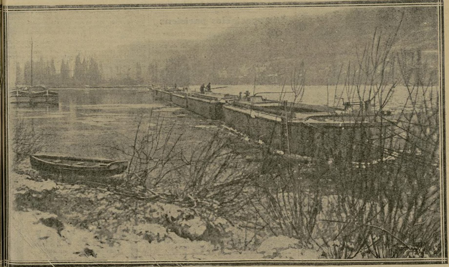
BARRAGE DE PÉNICHES EN FER, ÉTABLI PAR LE GÉNIE, POUR ARRÊTER LES GLACES, PRÈS DE ROUEN toute circulation a été rendue impossible par le nombre considérable de glaçons provenant de l'Oise. En raison de ce fait, de nombreuses péniches, chargées de charbon destiné au ravitaillement de Paris, n'ont pu quitter Rouen. Elles s'échelonnent sur kilomètres en amont de la ville. Les glaçons se sont accumulés et soudés autour d'elles.
