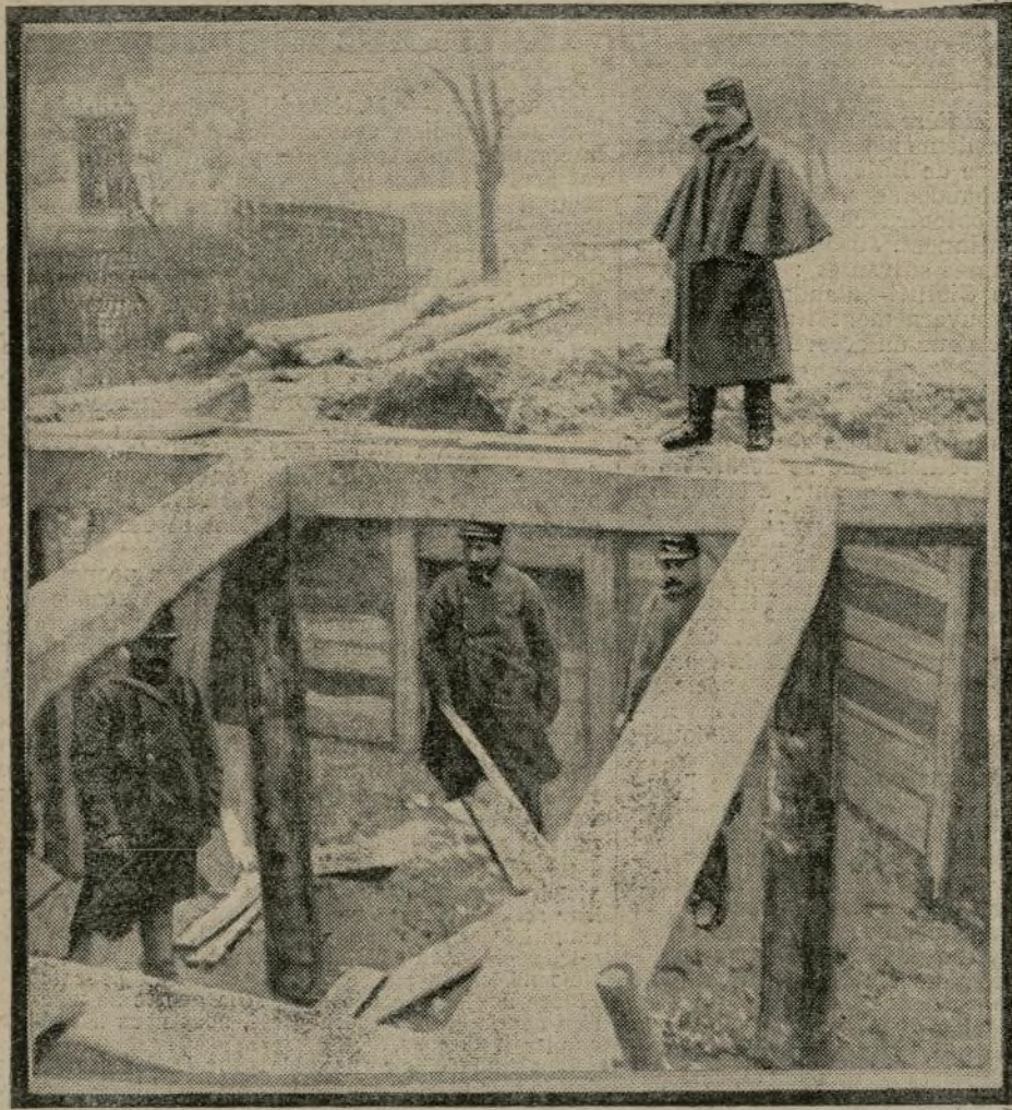
Pour éviter les surprises, toujours désagréables, de l'obus allemand, les Français ont agencé cette cave où, sur des poutres de ciment armé, ils se disposent à établir une carapace tutélaire.
