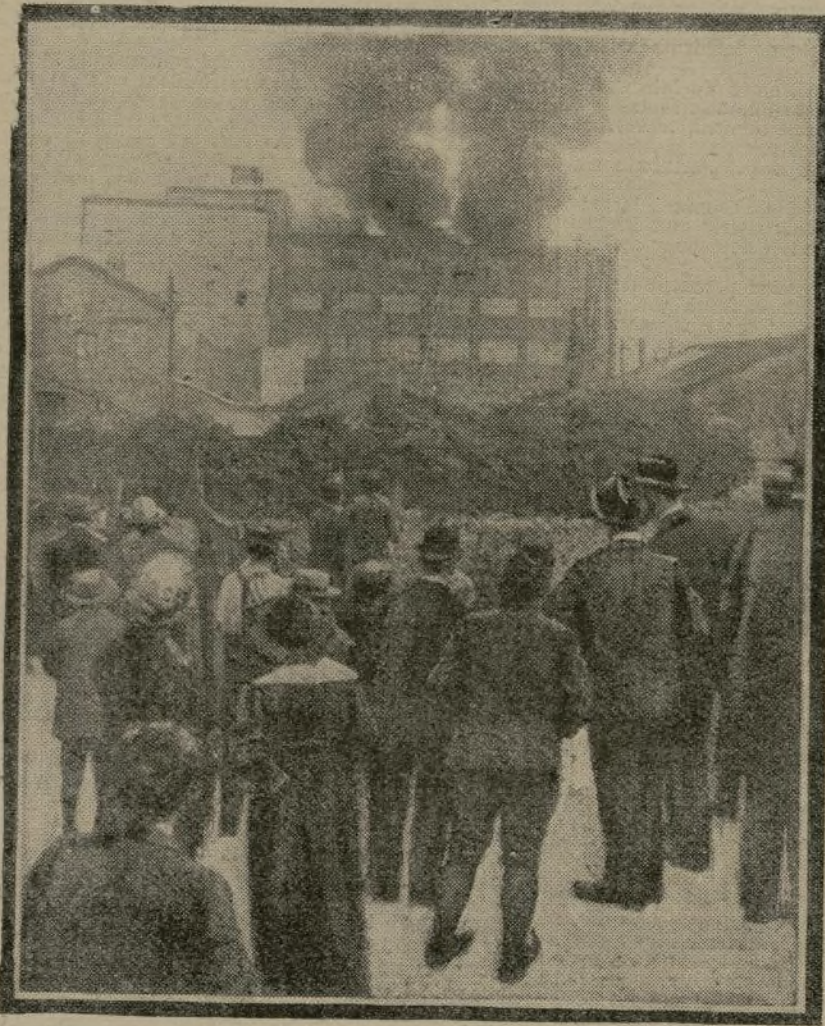
Avant-hier après-midi, à Clichy, cette usine, mise sous séquestre, fut la proie des flammes. Après quatre heures d'efforts, les pompiers de la région et de Paris réussirent à se rendre maîtres du feu. Les dégâts s'élèvent à plus d'un million.
