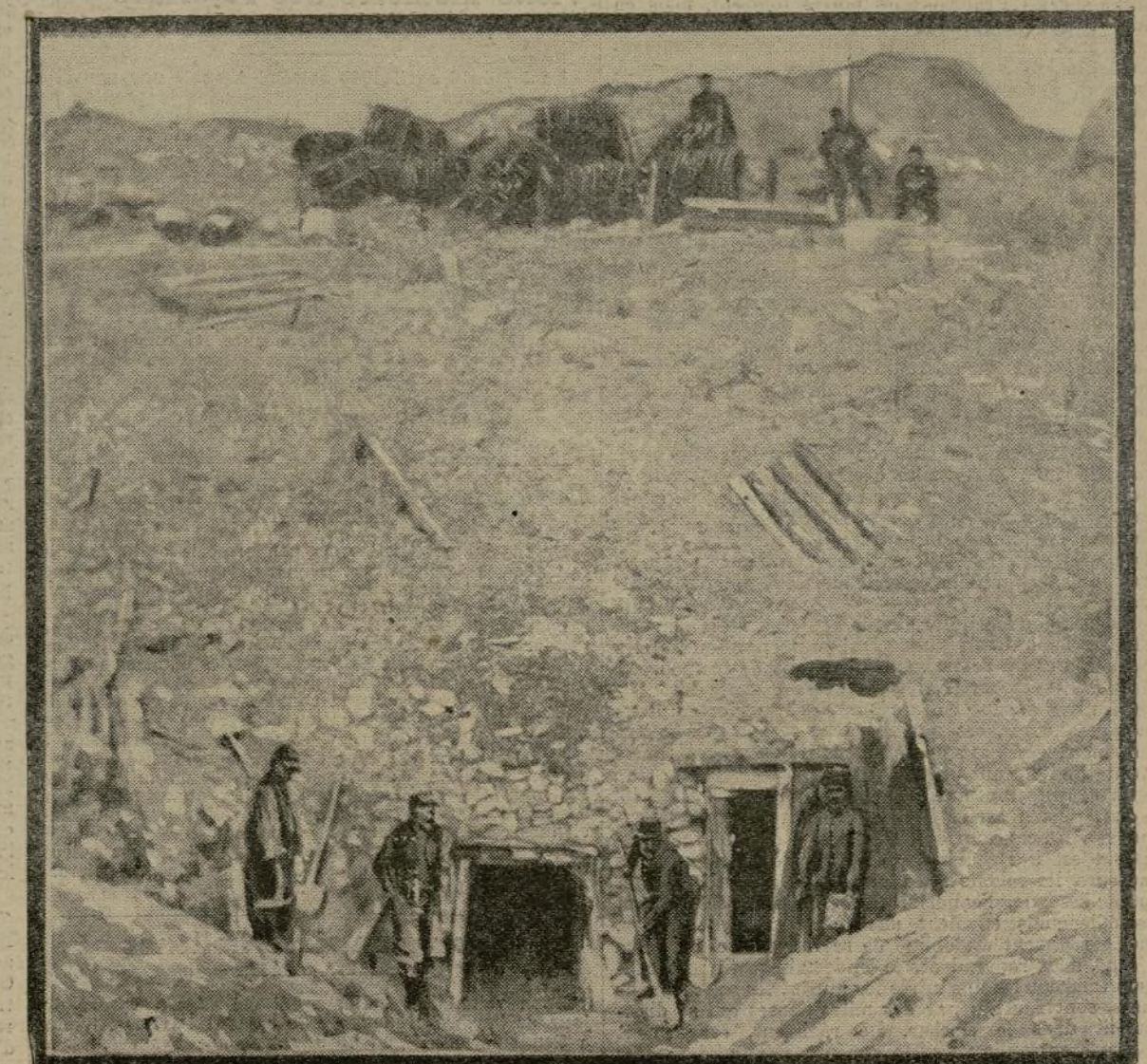
C'est un véritable travail de « mine profonde » que réalisent nos sapeurs lorsqu'ils foront des galeries dans l'intention d'aller, sous les tranchées ennemies, déposer des explosifs. Ces chemins sont revêtus de parements de bois dont on voit la charpente à l'issue du boyau.
