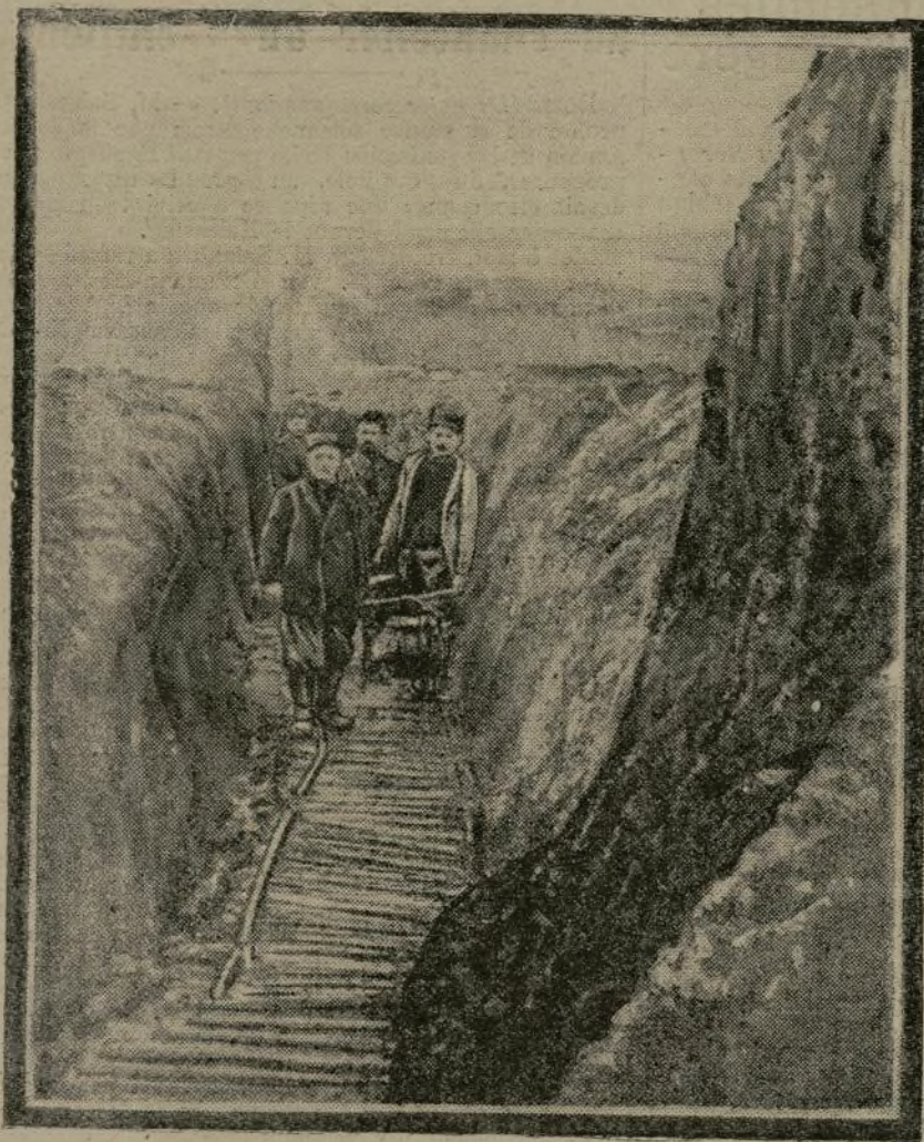
Boyau de ravitaillement qui, long de 1.800 mètres et aboutissant aux secondes lignes, permet de ravitailler les premières lignes, avec le minimum de danger.
