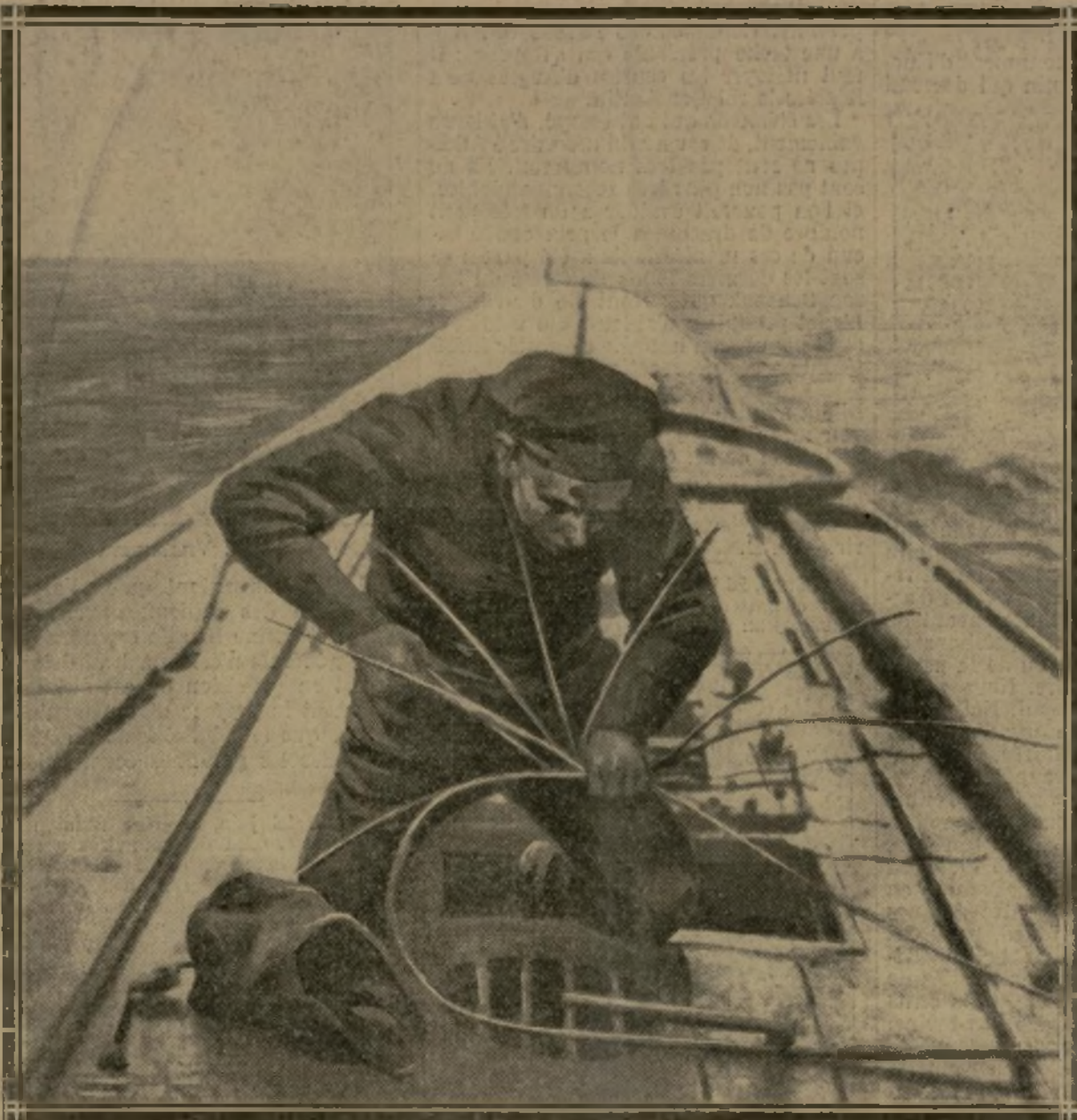
MATELOT FAISANT UNE ÉPISURE A UN CABLE MÉTALLIQUE, AU LARGE
