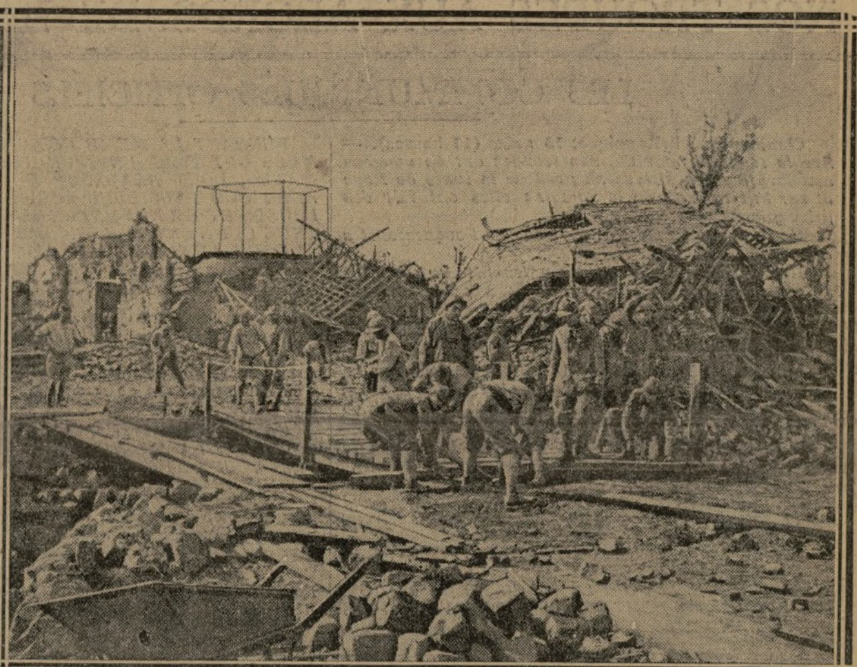
LA CONSTRUCTION D'UN PONT PROVISOIRE DEVANT LA GARE
