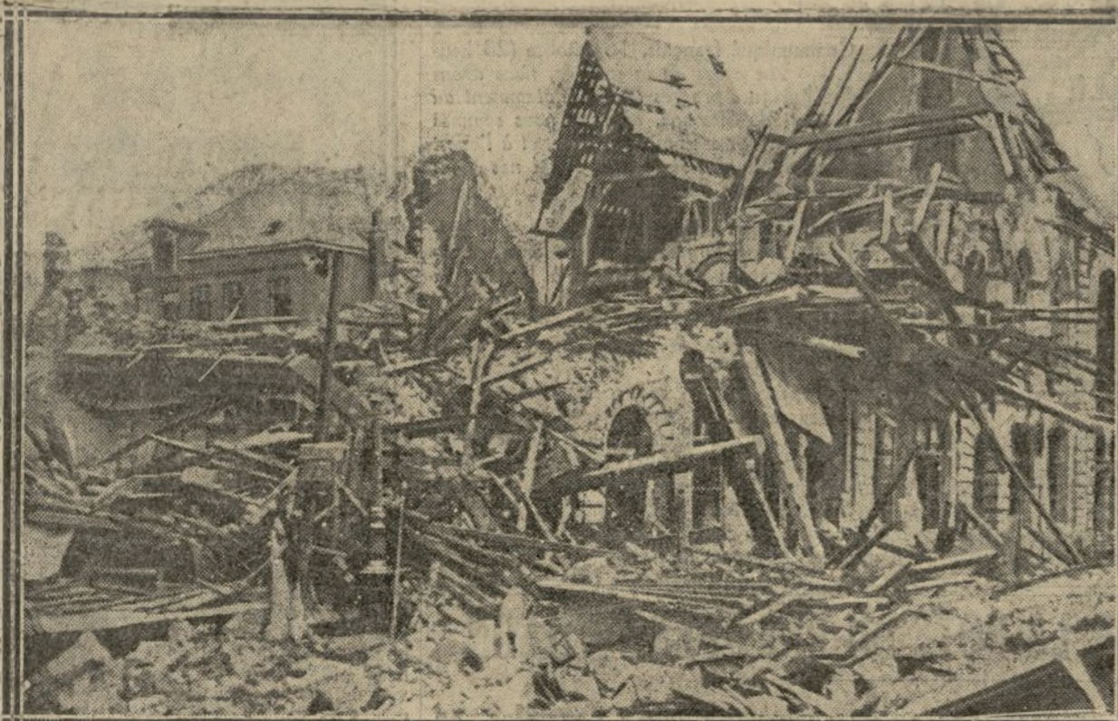
4 OCTOBRE : ROINES DE LA MAIRIE D'ARMENTIÈRES, QUI AVAIT ÉTÉ MINÉE
